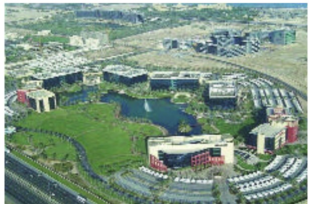
Luftansicht der Dubai Internet City
